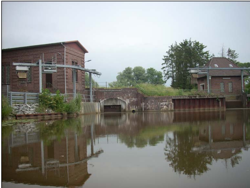
Foto 3: Schöpfwerk am Basbecker Schleusenfleth.
